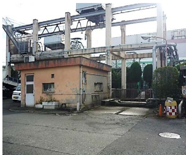
写真 3 洗砂槽 1号機 市岡処理場
