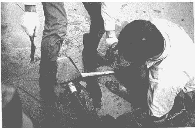
写真 14 高圧洗浄車に付属の大ノズル
