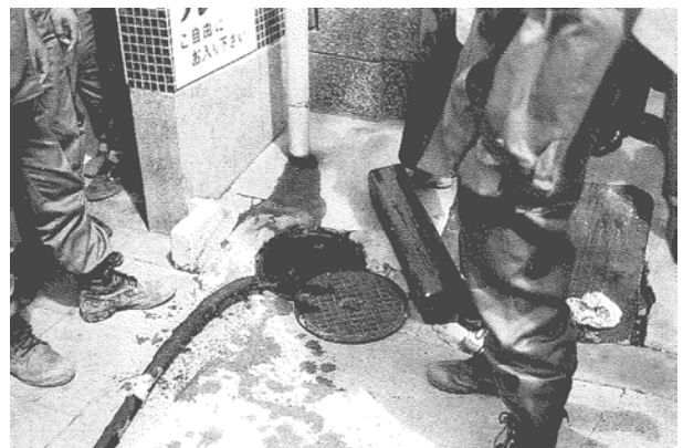
写真6 損耗した高圧ホース
