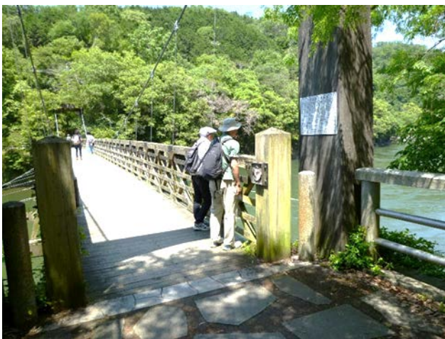
天ヶ瀬吊り橋
