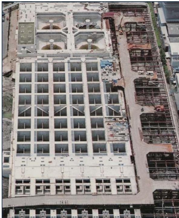
水深 10mの反応タンクと3階式沈殿池
