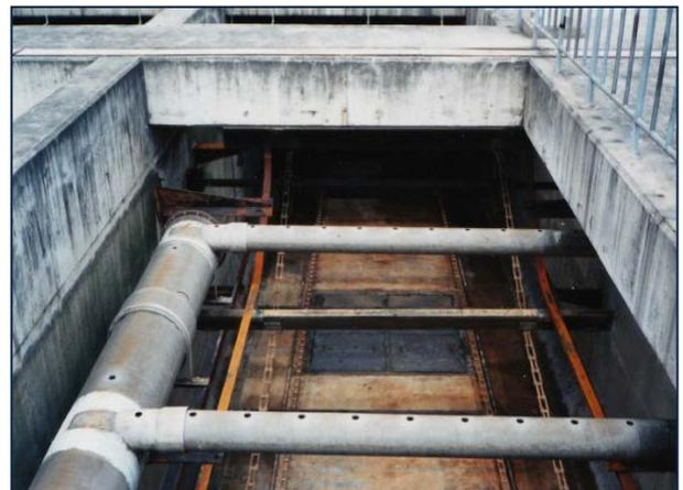
20~40m<sup>3</sup>/m<sup>2</sup>/日の範囲の水面積負荷では、各層間で処理水質の差異は見られない。良好な処
