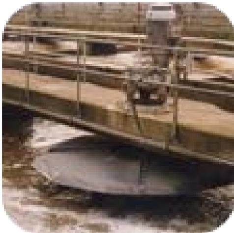
写真-3 バリー処理場納入のシプレックスタービンと類似の曝気装置
