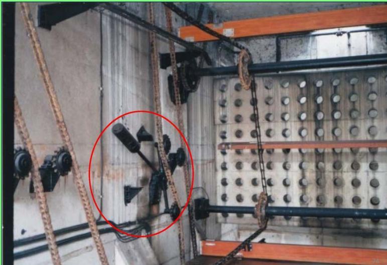
**[12・6]** 中層部、下層部ではフライトは流出管の上部に位置して、中床版の下面を摺動してスカムの堆積を防止しています。中床版と流出管の間に位置するフライトが見えます。
