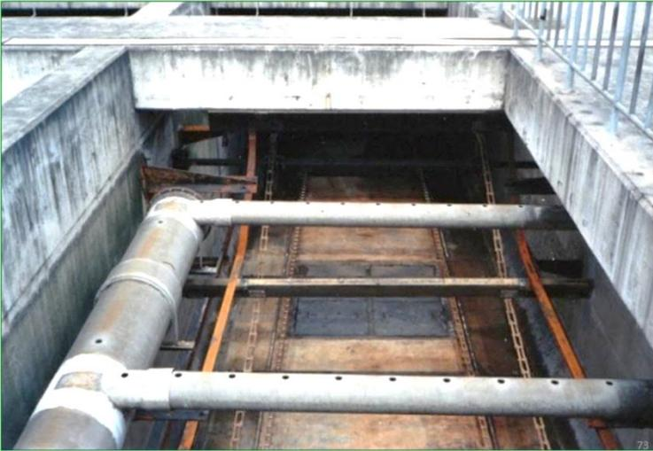
**[12・4]** 3層式最終沈殿池の上層に設置された流出管を示しています。主管の内径は500mm、枝管の内径は200mm、小孔の直径は40mmです。
