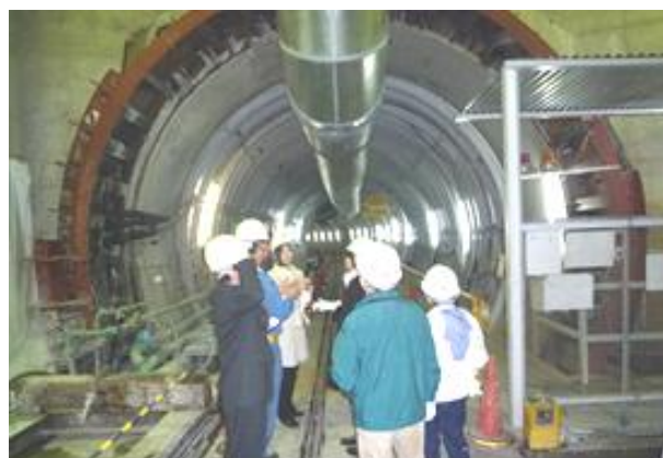
写真-5 シールド工事の見学【第1回】
