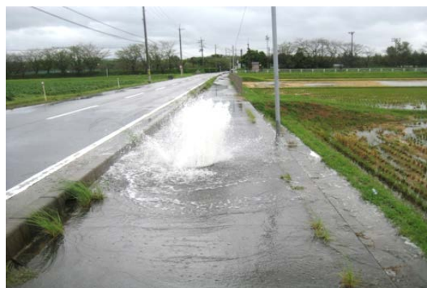
東近江市でのマンホールからの溢水の様子
