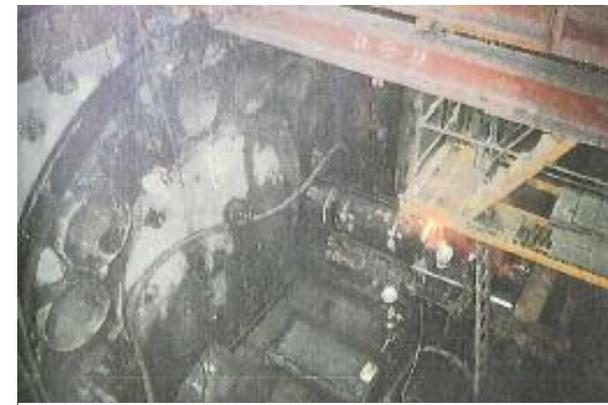
写真-9 鋼管の推進状況
