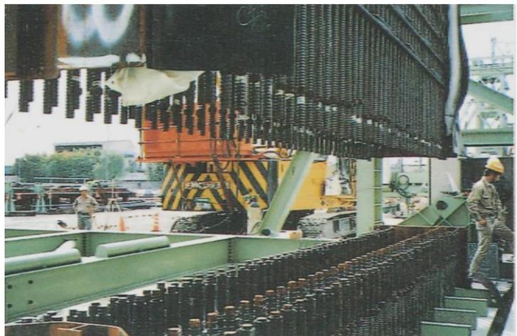
写真-13 鉄筋かごの継手部
