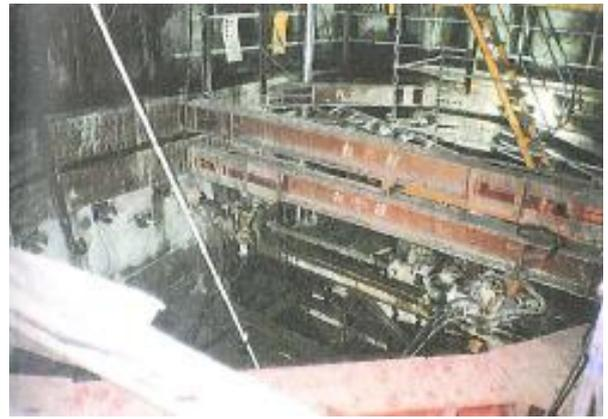
写真-7 水平注入施工状況
