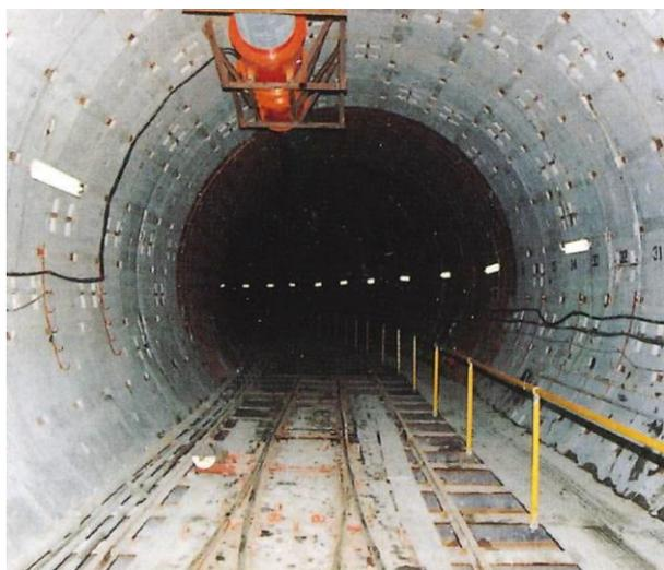
写真-3 2工区の一次覆工状況
