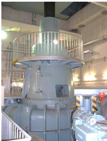
写真-16 雨水ポンプ (φ2400mm)
