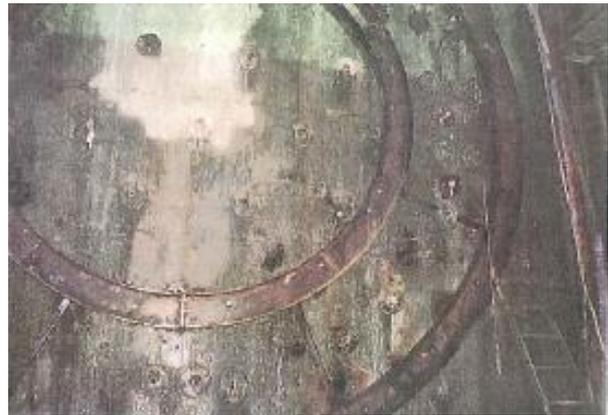
写真-8 鋼管推進用の定規設置状況
