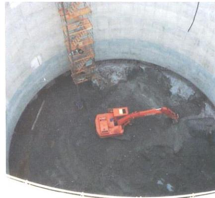
写真-1 津守立坑の掘削状況
