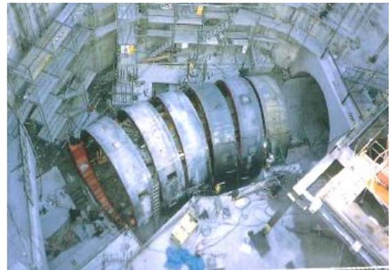
写真-5 インバート型枠の設置状況
