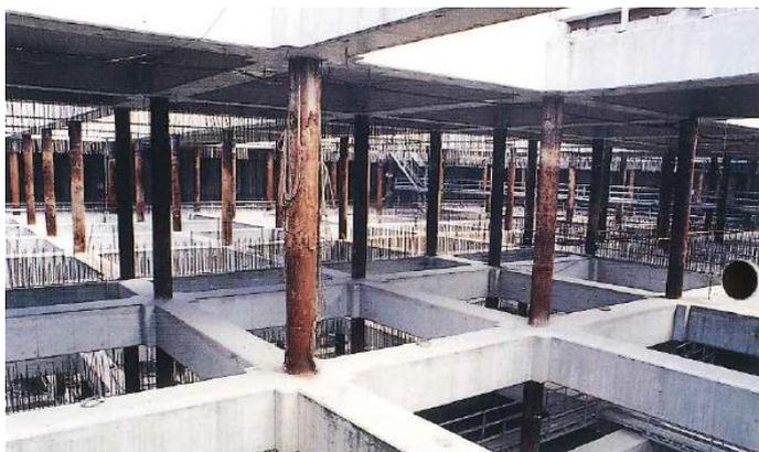
写真-14 RC支保工の構築
