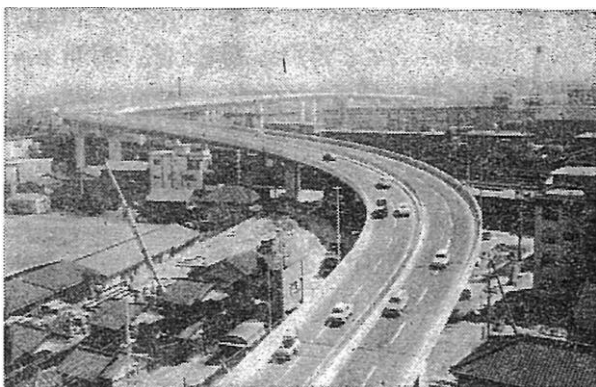
完成当時の天王寺バイパス（南側より）
