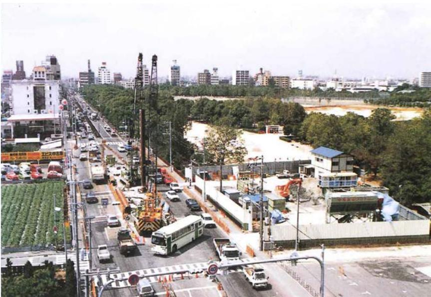
写真-2 鋼管矢板を施工中の長居立坑
