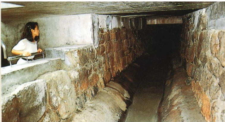
写真-7 太閤（背割）下水・見学施設内部
