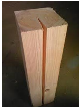
写真-3 柱の背割り
