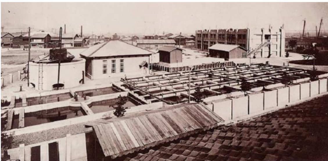
写真-5 市岡抽水所下水処理実験装置
